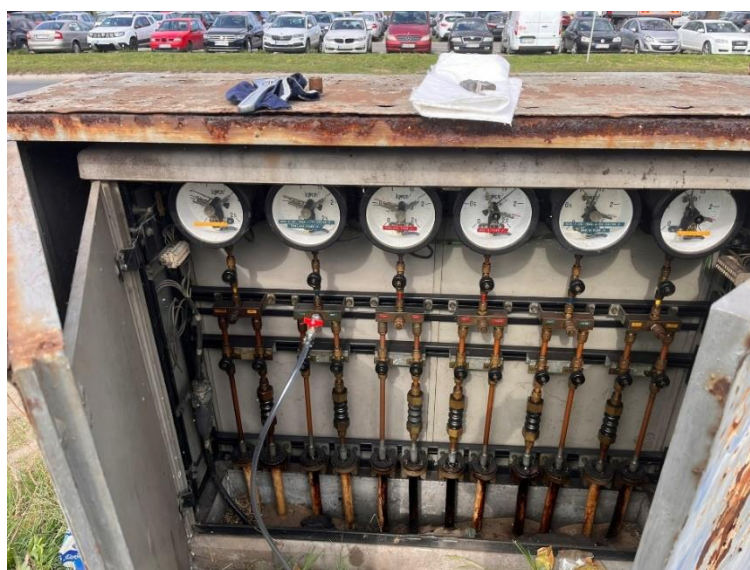
Slika 4: Povezivanje sistema za istakanje na ventile
